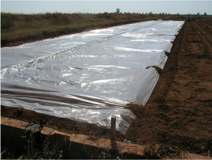
Figura 1. Posada del plàstic, punts de sustentació.
